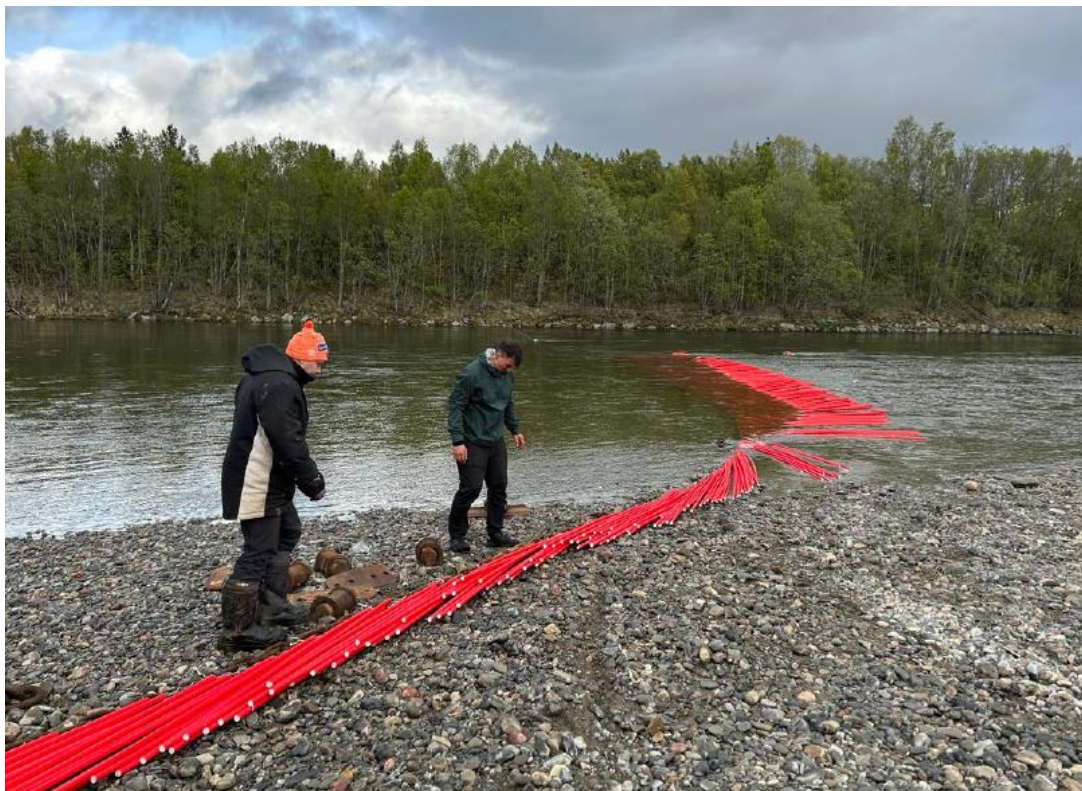
Figur 11: Ledegjerdene på 5 m festes i seksjoner til en større bunnkjetting og trekkes ut i elva. Forsterkes med flere lodd. Foto: Reisa Elvelag.
